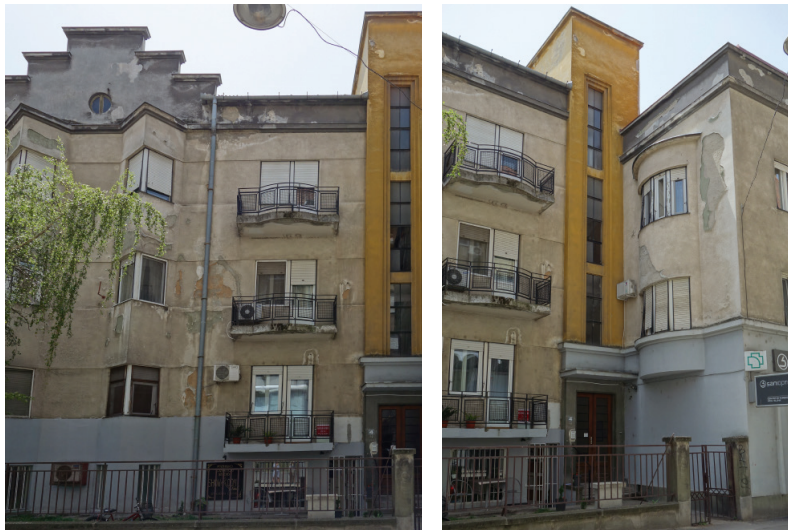
5.8. kép: A Dušan cár 4. alatti bérház, Bedő Ferenc tervei alapján építtette Grimm Viktor – Roth Ármin veje – 1933-ban (homlokzat: a–b)
