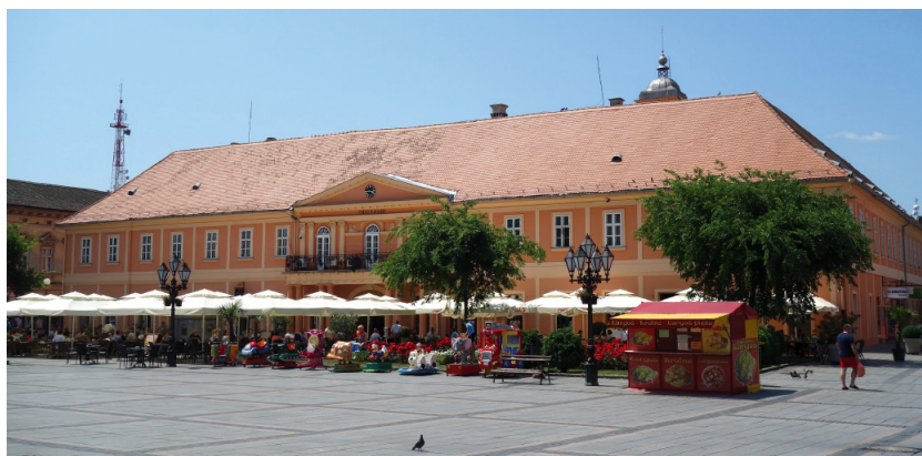
3.20. kép: A zombori régi városháza keleti homlokzata
